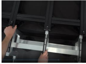
Ausrichten der Alu-Systemtreppe an der Unterkonstruktion der Terrasse.
