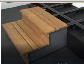
Dann kann der Deckbelag für die Terrasse verlegt werden.
