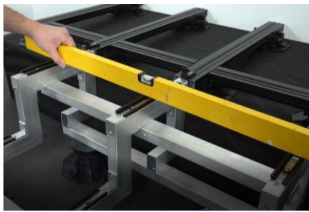
Ausrichten der Alu-Systemtreppe und Befestigung an der Terrasse
