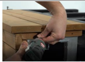
Nach dem Ausrichten muss diese an die Konstruktion geschraubt werden. Dazu mit einem 5 mm Bohrer die Fixierungsleisten vorbohren.
