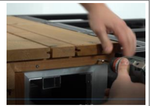
Dann mit den Bohrschrauben 4,8x38 mm anschrauben.
