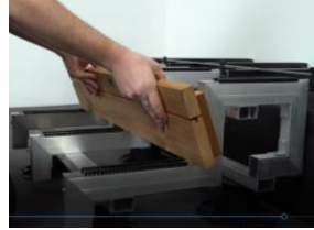
Die Trittstufen und Blenden müssen bauseits aus dem Dielenbelag der Terrasse konstruiert werden. Die Fixierungsleisten und Schrauben sind im Lieferumfang der Systemtreppe enthalten. Die Verschraubungspunkte der Leisten unter den Dielen, die an der Außenseite der Wangen liegen, sind auf die Stufen-/Blendenmaße abzustimmen.
