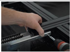
Alu-Systemtreppe in Längs- und Querrichtung ausrichten. Danach muss die Konstruktion mit der Terrasse oder dem angrenzenden Bauwerk fest verbunden werden. Dabei kann ein flaches Profil oder Winkel zur Anbindung dienen. Die Befestigung muss den örtlichen Gegebenheiten angepasst und bauseits beschafft werden.
