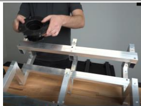
Fixieren der Terrassenlager
