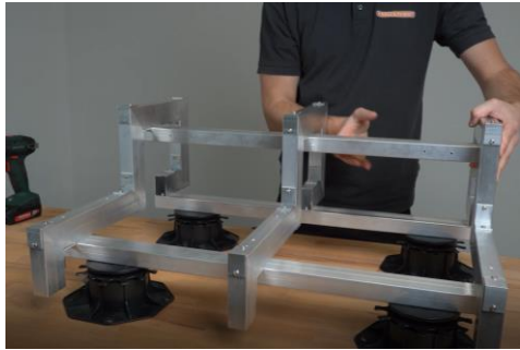
Fixieren der Terrassenlager
