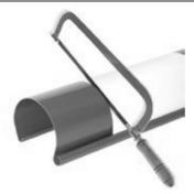
Dachrinnen werden mit einer Metallsäge auf passende Länge gebracht.
